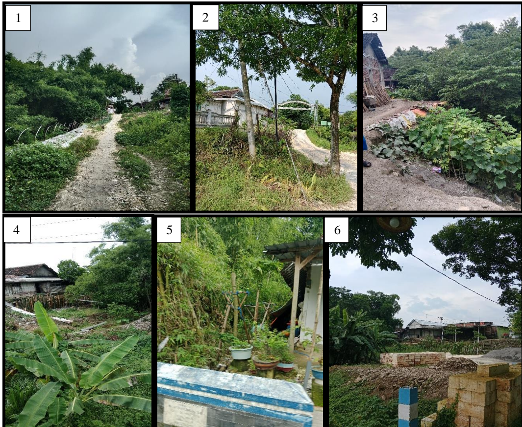
Gambar 8: Hasil Survey Lapangan : 1) Longsor pada jalan dusun di Desa Dayu Kidul. 2) longsor pada jalan utama di Desa Dayu Kidul. 3) longsor pada rumah di Desa Kedungrejo. 4) longsor pada rumah di Desa Kedungadem. 5) longsor pada Rumah di Desa Kedungadem. 6) Longsor pada rumah di Desa Geger.
